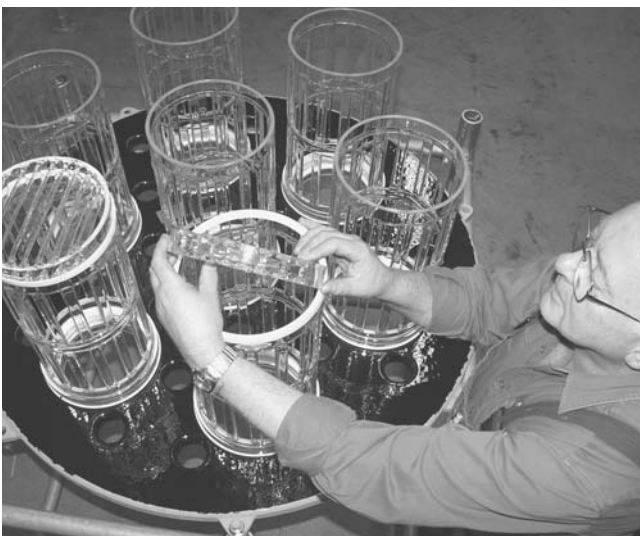
Abb. 1: Montage eines CORE-TRAY DN 1000, hier für Füllkörper mit Glasrost
